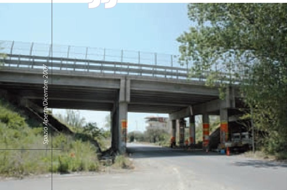
Le campate esterne poggiano sulle spalle da un lato e sul pulvino dall'altro, mentre quella interna poggia sui pulvini. Le due file di pile sono composte da cinque elementi circolari di diametro 1 m ed altezza 6 m, con interasse 5,55 m, sui quali è disposto il pulvino.
